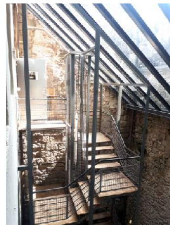
escalier provisoire et verrière, état en 2019 © g+r
