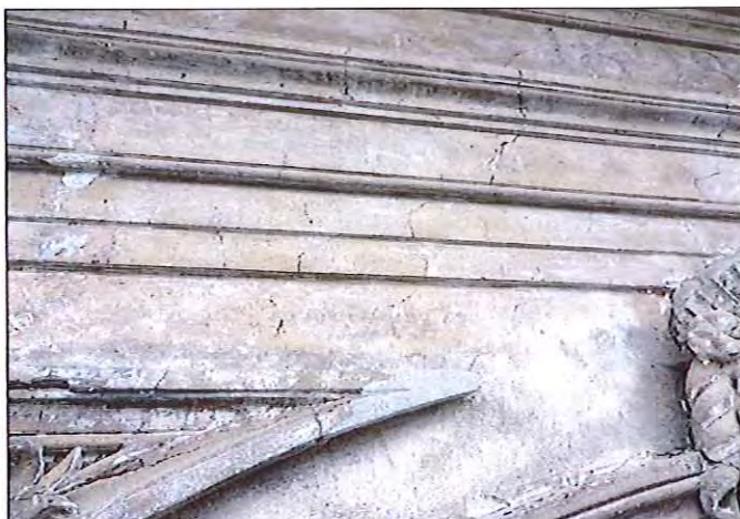
Photo modénature refaite rénovation antérieure
