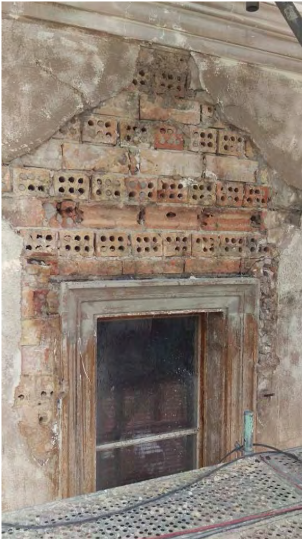
Modénatures déposées entièrement
