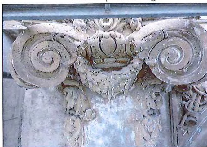
Photo après sablage
