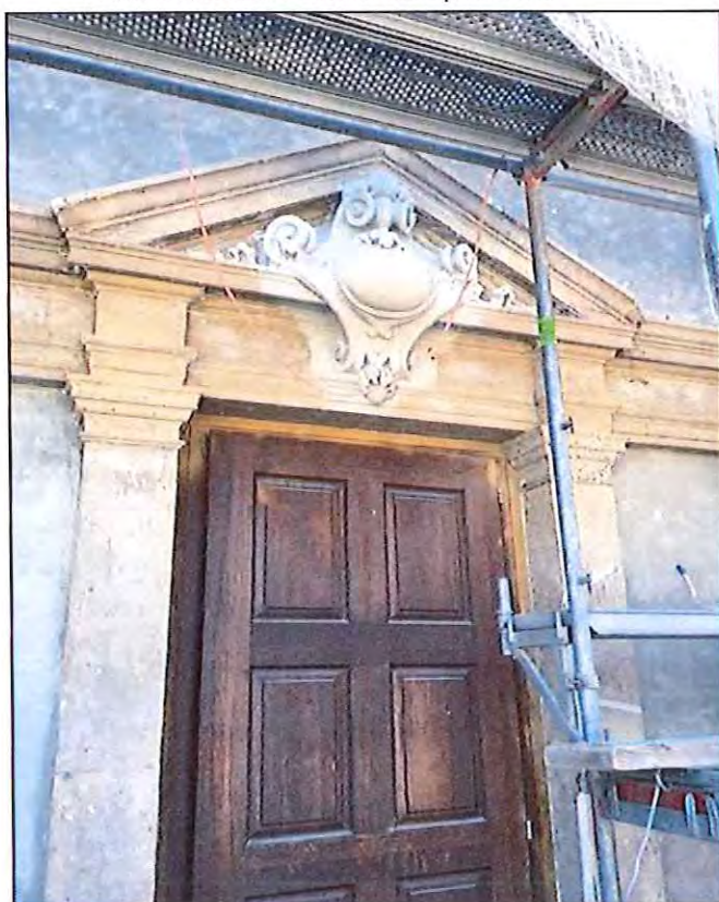
Photo modénature remplacée
